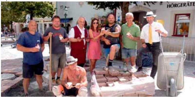
Kurze Pause bei den Ausbesserungsarbeiten in der Innenstadt
