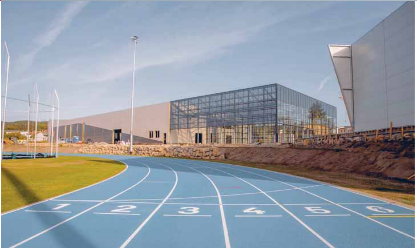
Im Bereich der Oberen Langäcker wurden in den vergangenen Monaten kräftig gebaut. Angrenzend an die neue Leichtathletikarena entstehen die beiden großen Hallen des neuen Raiffeisen Lagerhauses (im Bildhintergrund).
